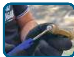
Extracción de junta
